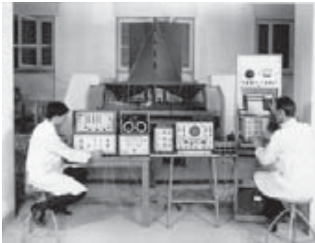
02 Modell der Kathedrale von San Francisco im Mst. 1:36.89 während der Prüfung prova dinamica auf vibrierendem Tisch, 1965 (Archivio Storico ISMES)
