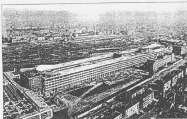
Blick auf den von Mattè Trucco errichteten und nun von Renzo Piano umgebauten Lingotto, die links daran schliessende Messehalle, die Geländeanlagen und die ehemalige Arbeiteriedlung
