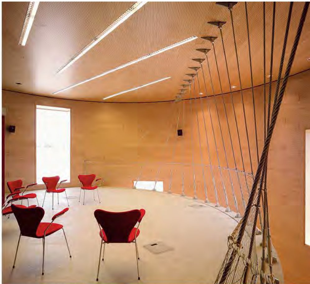
18–20 Das vom «Fass des Diogenes» inspirierte Innenleben des ehemaligen Tanks mit dem an Stahlseilen aufgehängten Betonboden (Bilder: Wehrli Müllen Fotografen)
